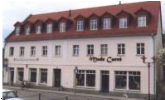
Ansicht nach Sanierung
