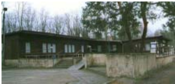
Ansicht vor Sanierung
